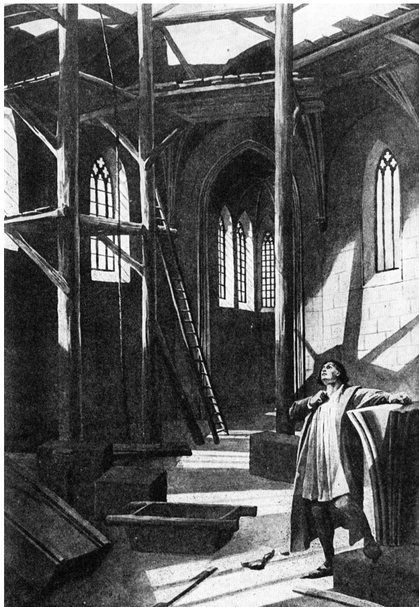
Upjal zrak vzhůru ke klenutí, jenž se šěřilo a černalo v trámovi.
